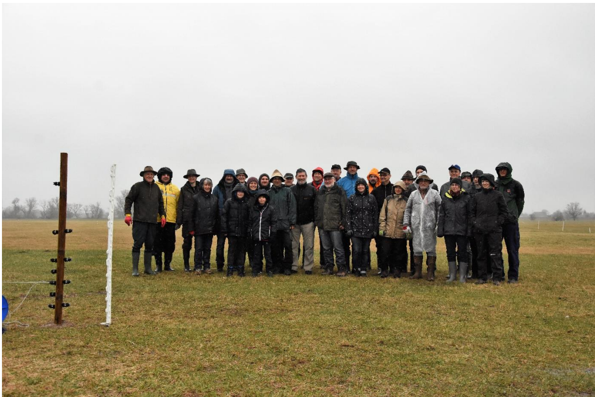
Anlage 6: Stöcklwörth und Gmünder Au – Zaunaufbau
